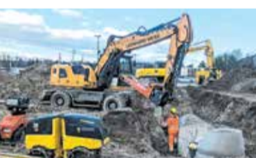
Die Bauarbeiten sind in vollem Gange. Foto: Luca Schmidt
